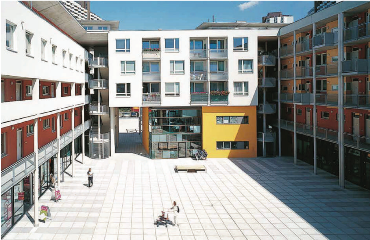
Vista peatonal del patio interior del alojamiento intergeneracional construido.
