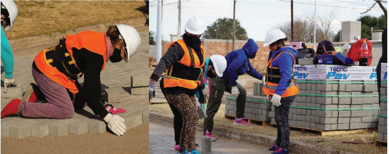
Obra de adoquinado urbano. Las Perdices, Provincia de Córdoba. Fuente: Diario el Puntal, 2021.
