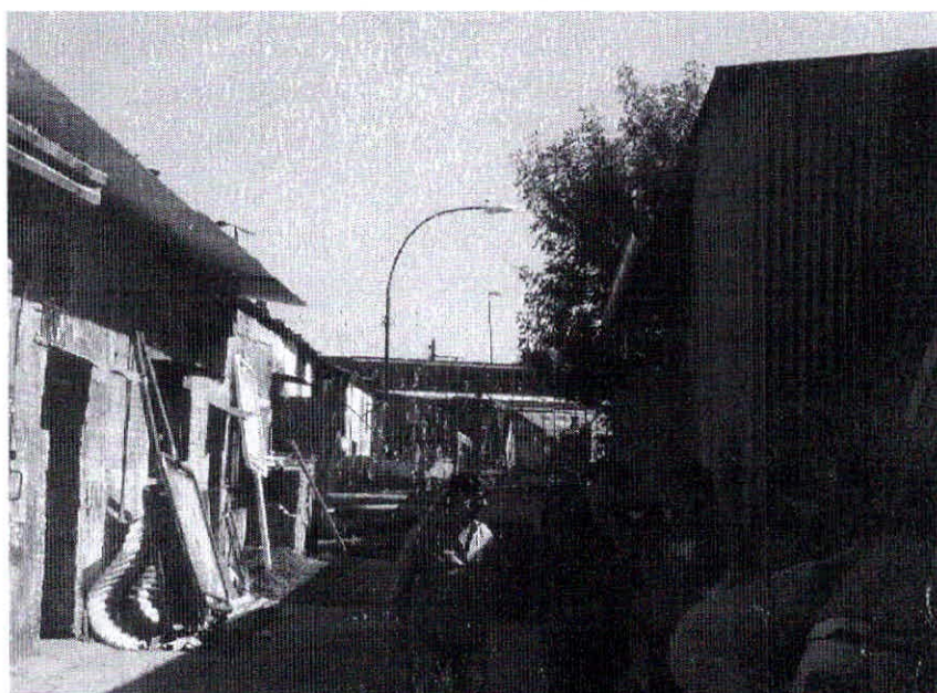
Portón calle interna
