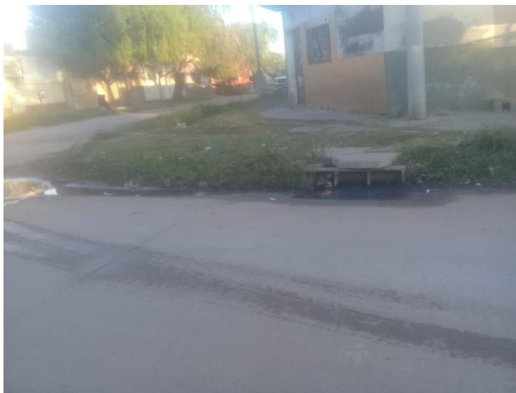
Foto 43: Boca de Tormenta sobre A. Aguado lado oeste colapsada. Foto 44: Losa N°101, lado oeste
