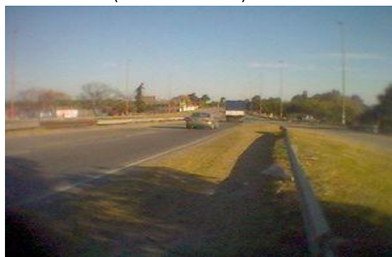
Imagen II-2 – Acceso por el sector Suroeste (Av. 27 de Febrero)
